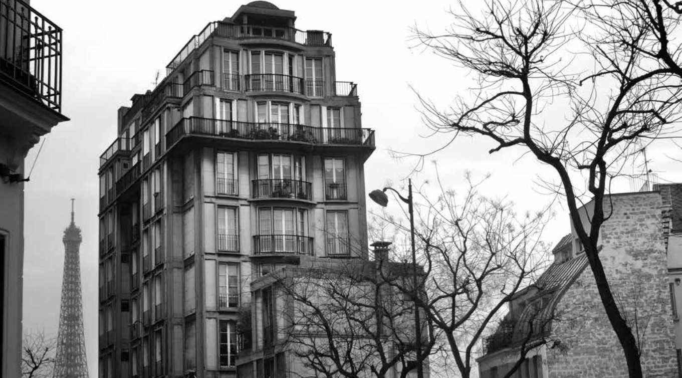
Immeuble D'Habitation Rue Raynouard, Paris, em Perret na França e Argélia (2011-12).
